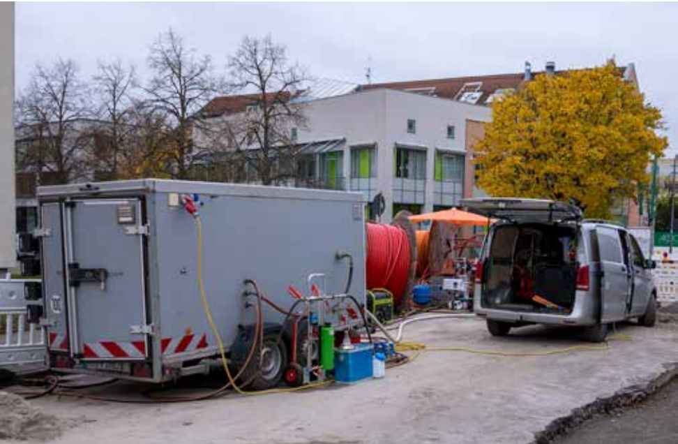
Befüllung des neuen Fernwärmesegments an der Friedrich-Ebert-Straße mit rund 380.000 Liter aufbereitetem Wasser. Über die rund 270 Meter lange Strecke werden sieben Gebäude der Baugenossenschaft Familienheim mit Fernwärme versorgt — ein weiterer Meilenstein für die klimafreundliche Wärmeversorgung der Innenstadt.
