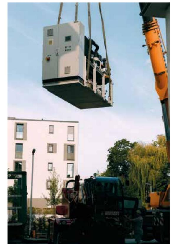
Anlieferung des neuen Blockheizkraftwerks für das Joffre-Wohnquartier: Mit 499 kW elektrischer Leistung und einer 440 kW Wärmepumpe steigern die Stadtwerke Rastatt die Effizienz der Wärmeversorgung und nutzen Abwärme noch besser.
